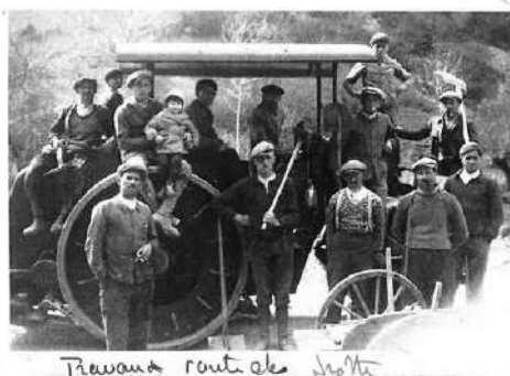
Travaux sur la route des Grottes
